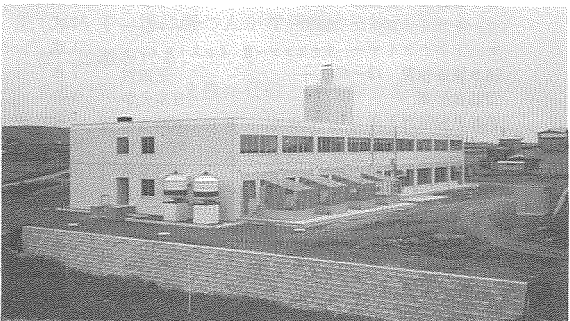
庁舎南西面およびグリーンハウス
